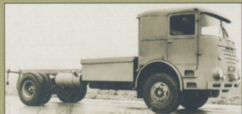
Feuer unter'm Hintern: Die Nutzung von Unterflur-Lastwagen für Transporte der Gefahrenklasse A 1 (z.B. Tankwagen) verlangte nach besonderer Abschottung des 'Verbrennungsmotors'. Oben ein Burglöwe U, darunter ein LU 11/16.
