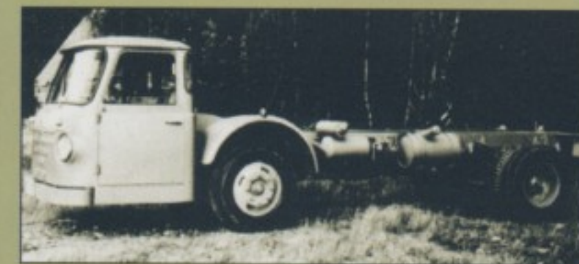
Prototyp von 1963: Büssing-Fahrgestell LU 5/10 mit niedriger Kabine.
