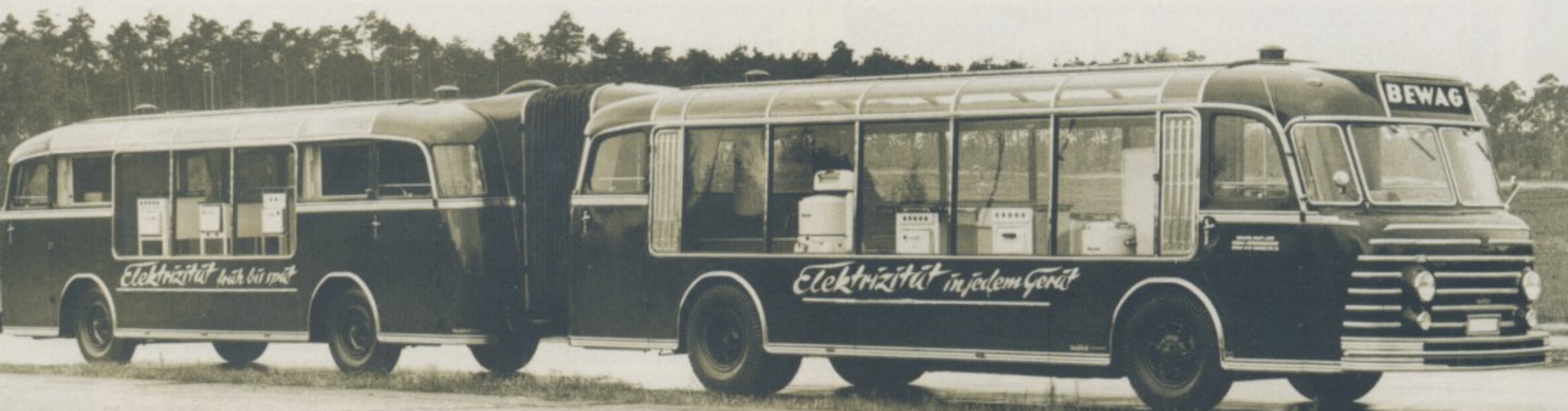
◀ ◀ Rückblick: Ebenfalls in die Reihe der Sonderfahrzeuge mit Unterflurmotor gehört dieser 1950 von Gaubschat für die Berliner BEWAG karosierte Faltenbalgzug auf dem Chassis eines Büssing 5000 TU. ▼
