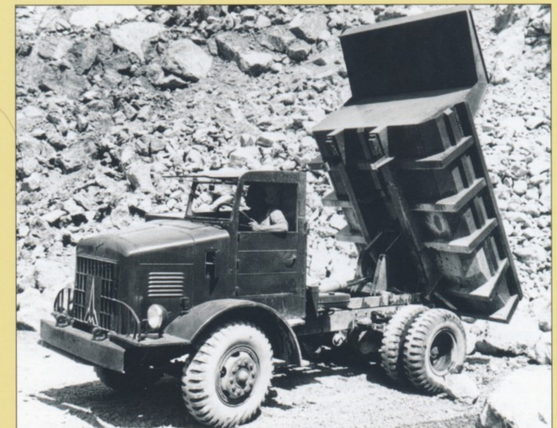
Robustes Kriegsgerät: International H-542-11 (M 426), 1944 für die US-Army gebaut, 1950 mit Deutz-Diesel und Meiller-Mulde ‚germanisiert‘.
