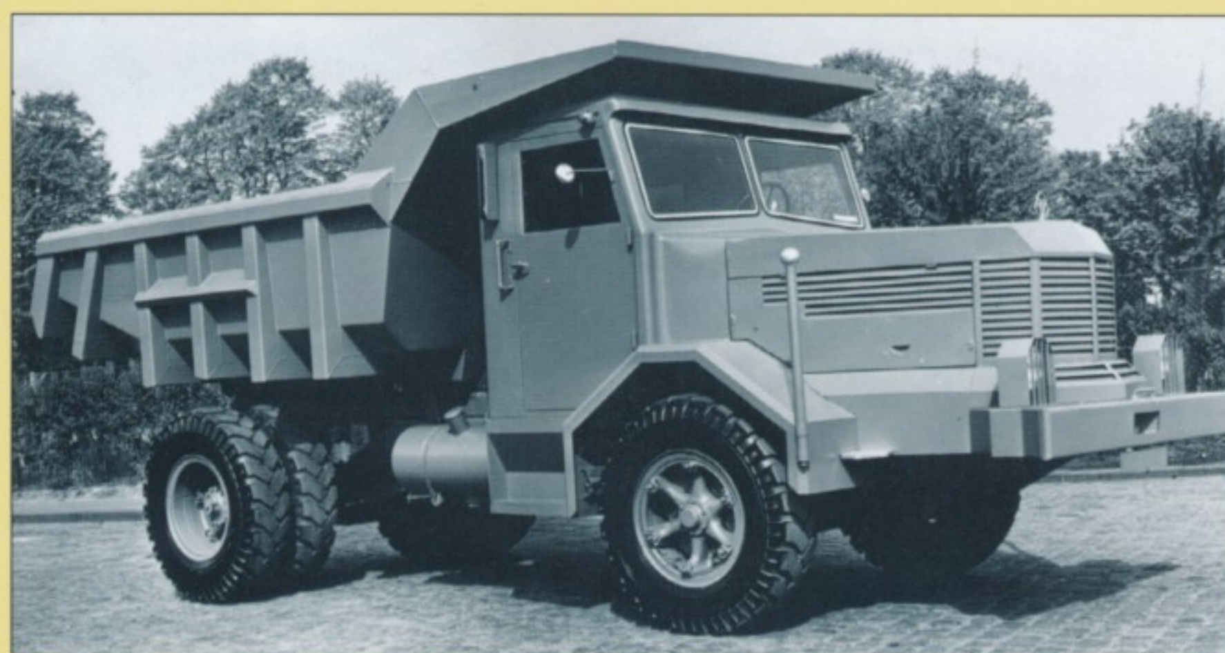
Vom Vorbild zum Konkurrenten: Ein deutscher Kunde erhielt 1953 diesen Mack LV (4x2) mit Meiller-Mulde für ein Gesamtgewicht von 39,5 Tonnen.
