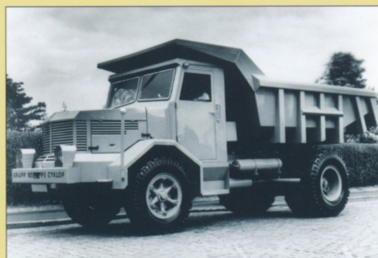
Ab 1957 ermöglichte der Fünfzylinder-Zweitaktmotor aus dem Tiger beim Cyclop (MK 15 C 5) eine verkürzte Motorhaube.
