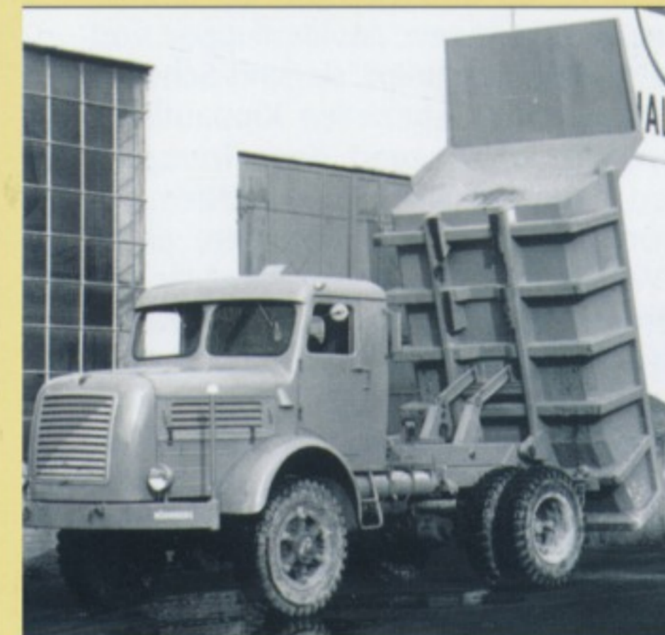
Mit luftgekühltem Deutz-V8: Faun F 68/36 KA (4x4) aus dem Jahr 1956.
