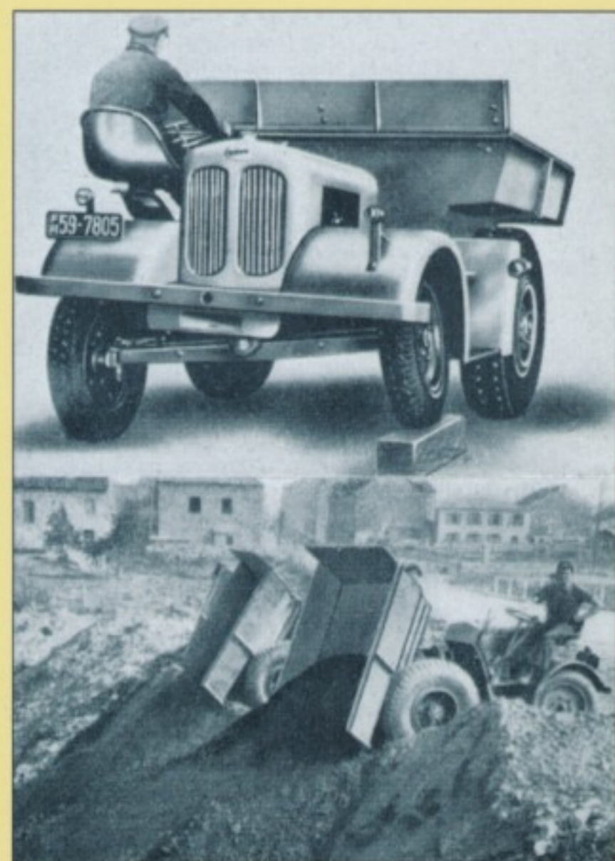
▲ Hinten ist, wo die Mulde sitzt: Der O&K-Autoschütter AS 600 (4x2) trug immerhin 8,4 Tonnen und sah schon fast erwachsen aus.
