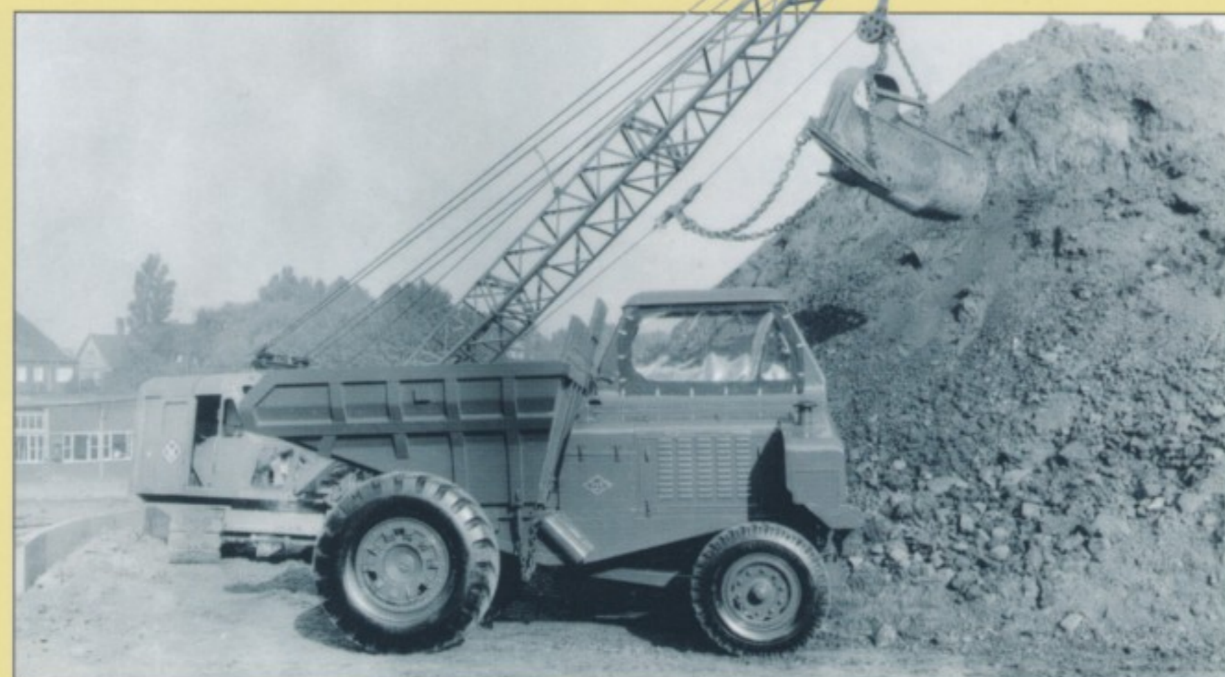
▲ Hinten ist, wo die Mulde sitzt: Der O&K-Autoschütter AS 600 (4x2) trug immerhin 8,4 Tonnen und sah schon fast erwachsen aus.
