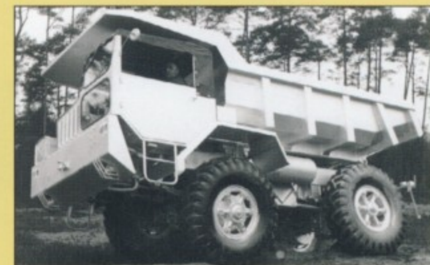
Klein, aber oho: 1956 stellte Faun den K 10 (4x4) für 10-11 Tonnen Nutzlast vor.
