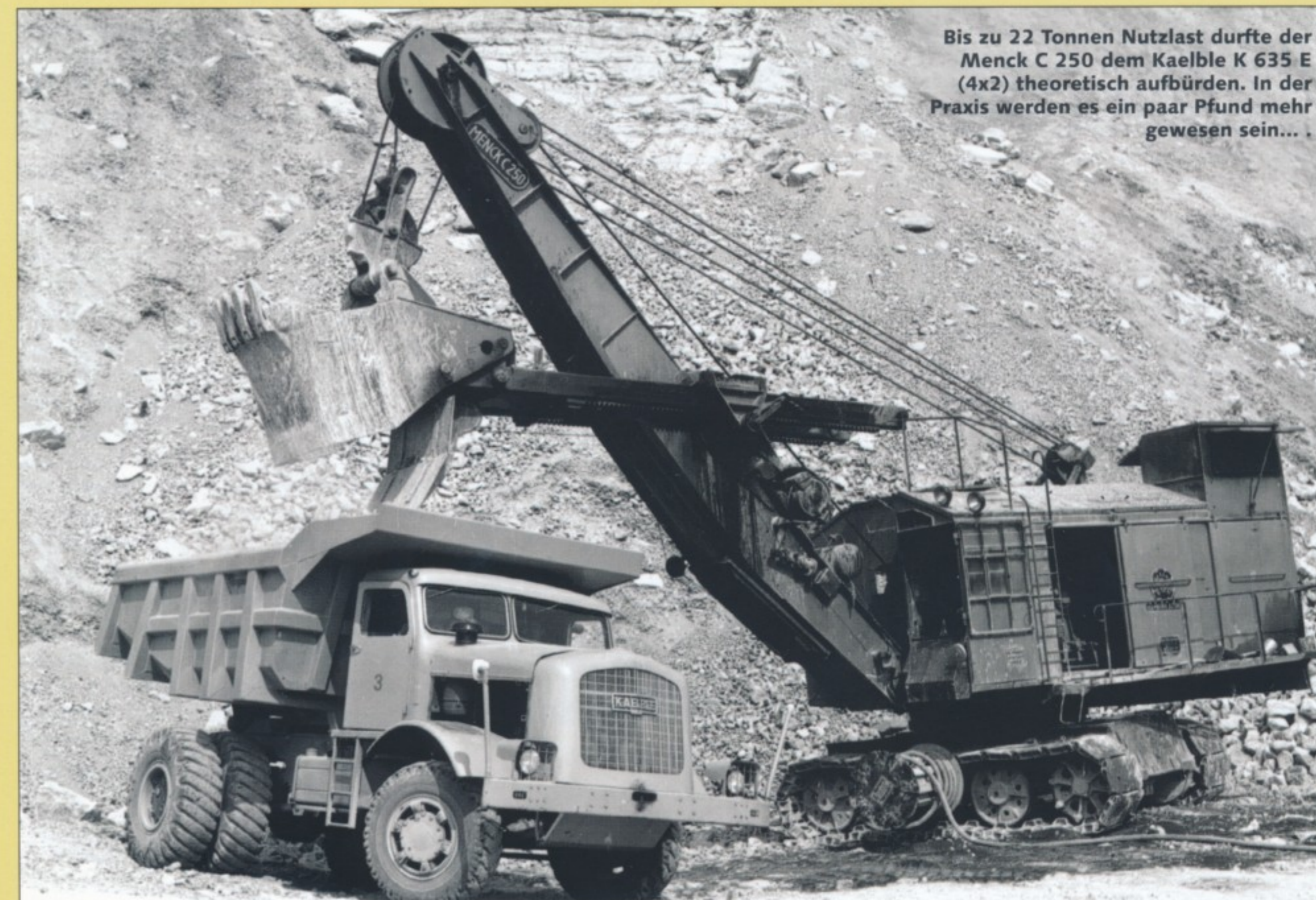
Mit und ohne Allrad: Der K 635 E (4x2), hier mit Felsmulde von Meiller, erschien bereits 1958, sein Allrad-Pendant KV 635 E (gr. Bild) folgte im Jahr darauf.
