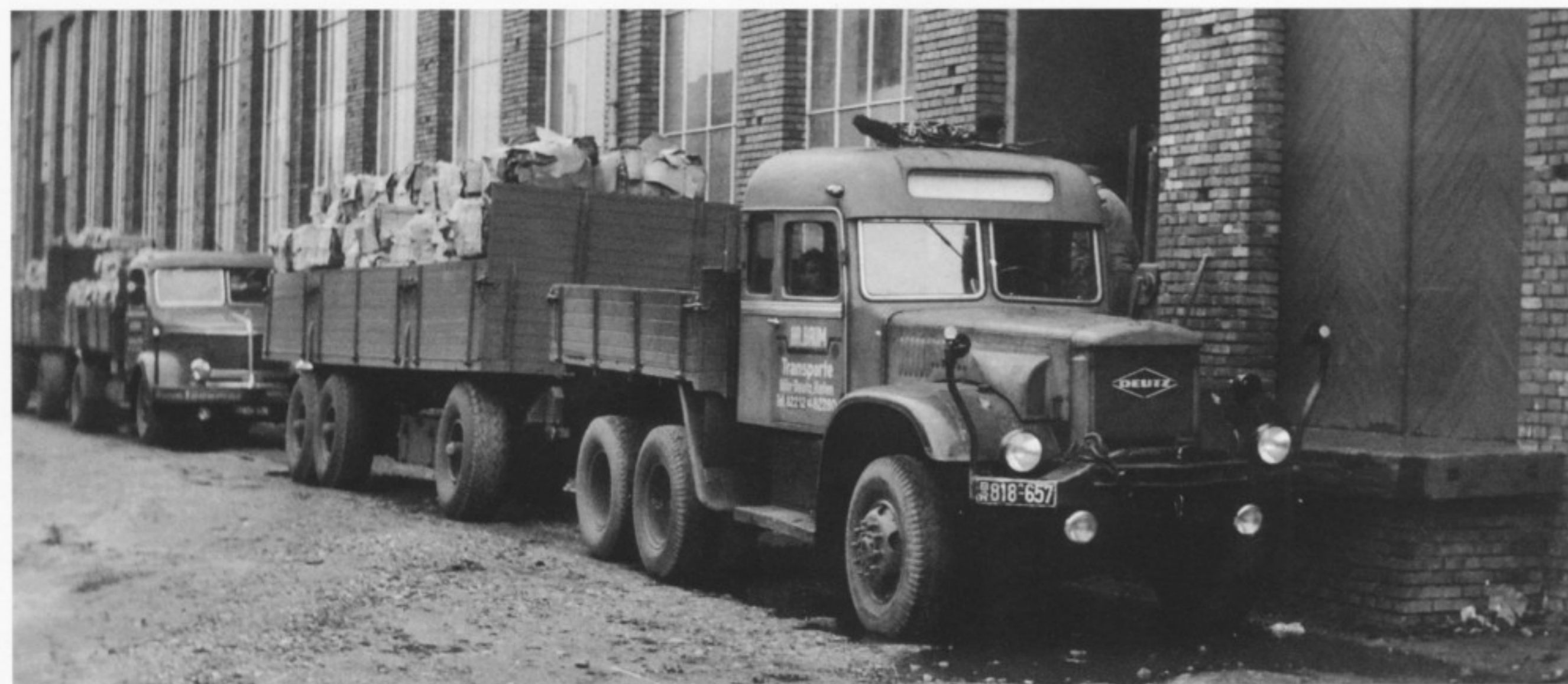
Nachrüstung: Mit Fahrerhaus von Tang und 135 PS-Einbaudiesel von Deutz erlebte dieser Diamond einen zweiten Frühling. ▼
