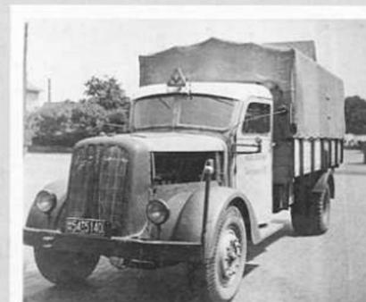
▲ Mit Flüssiggas mobil: 6,5-Tonner Vomag etwa 1949.
